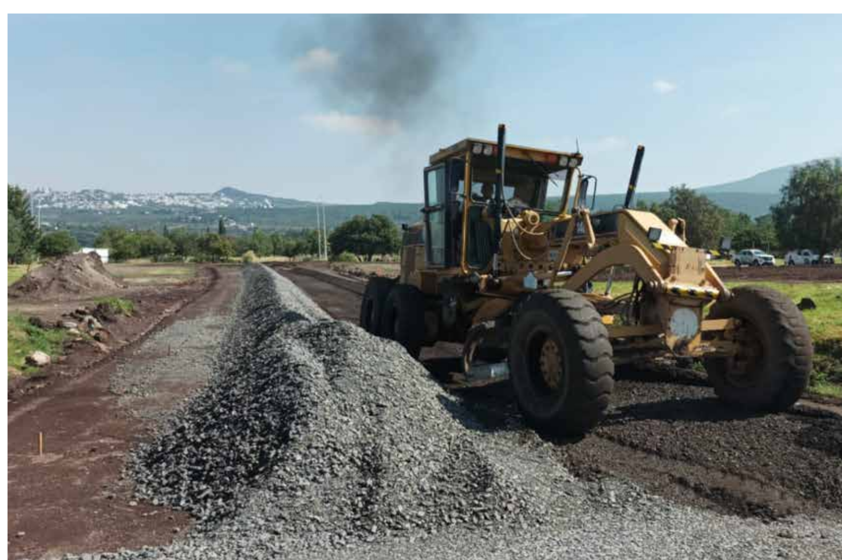
TÉRMINO DE CAPA SUBRASANTE Y SUMINISTRO CIPRÉS
