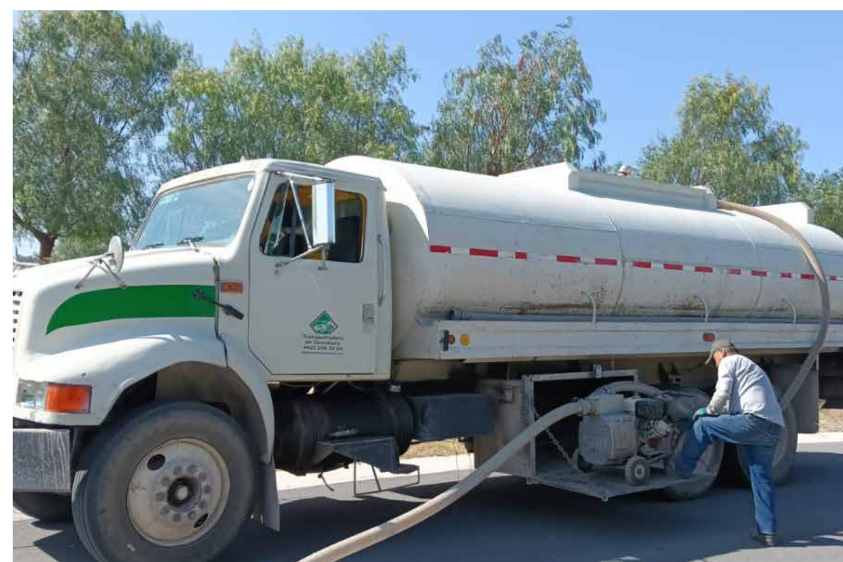
RETIRO DE AGUAS RESIDUALES VIVIENDAS DE ARBOLEDA 1 Y 2
