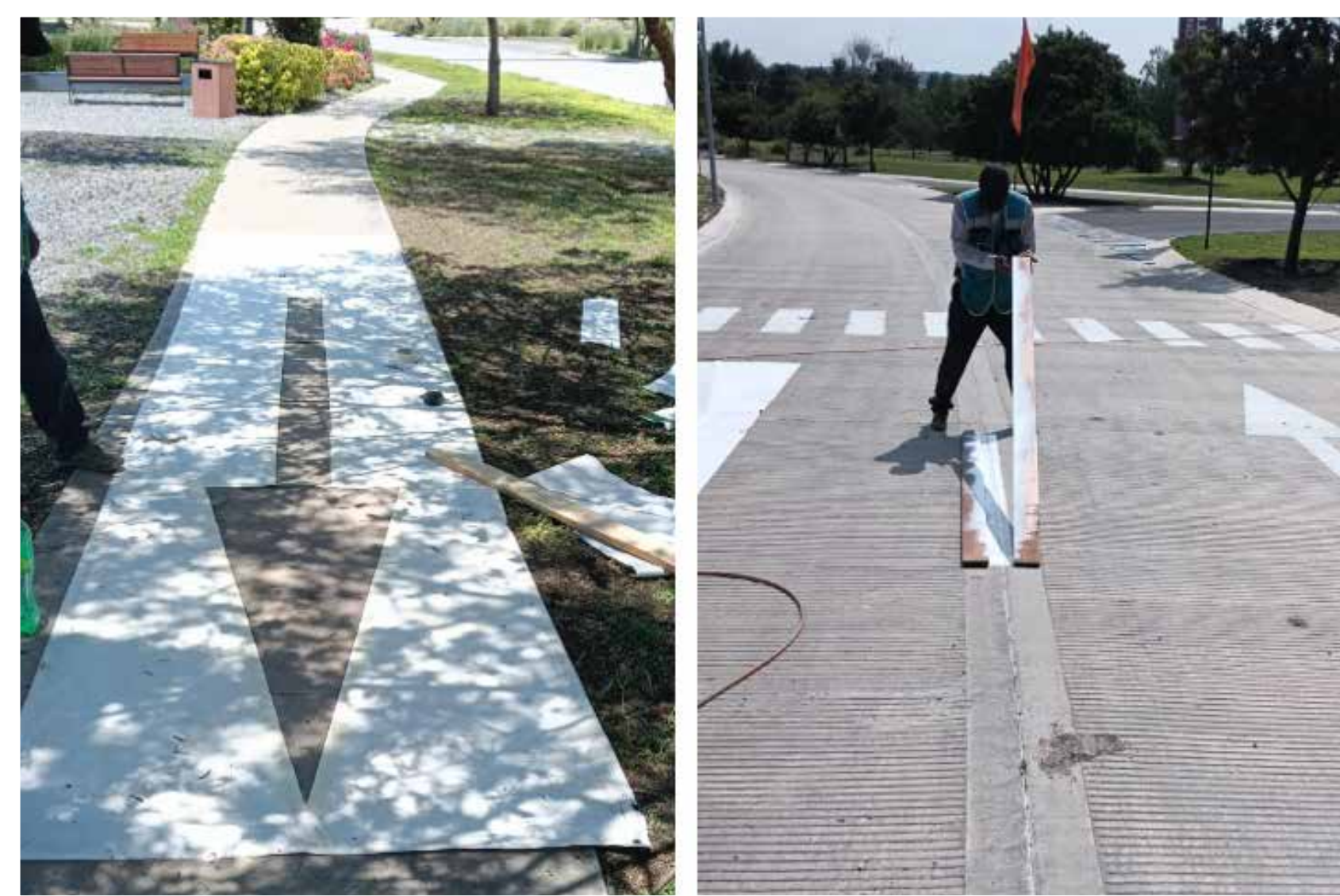
MANTENIMIENTO SEÑALÉTICA BLVD. RÍO GRANDE
