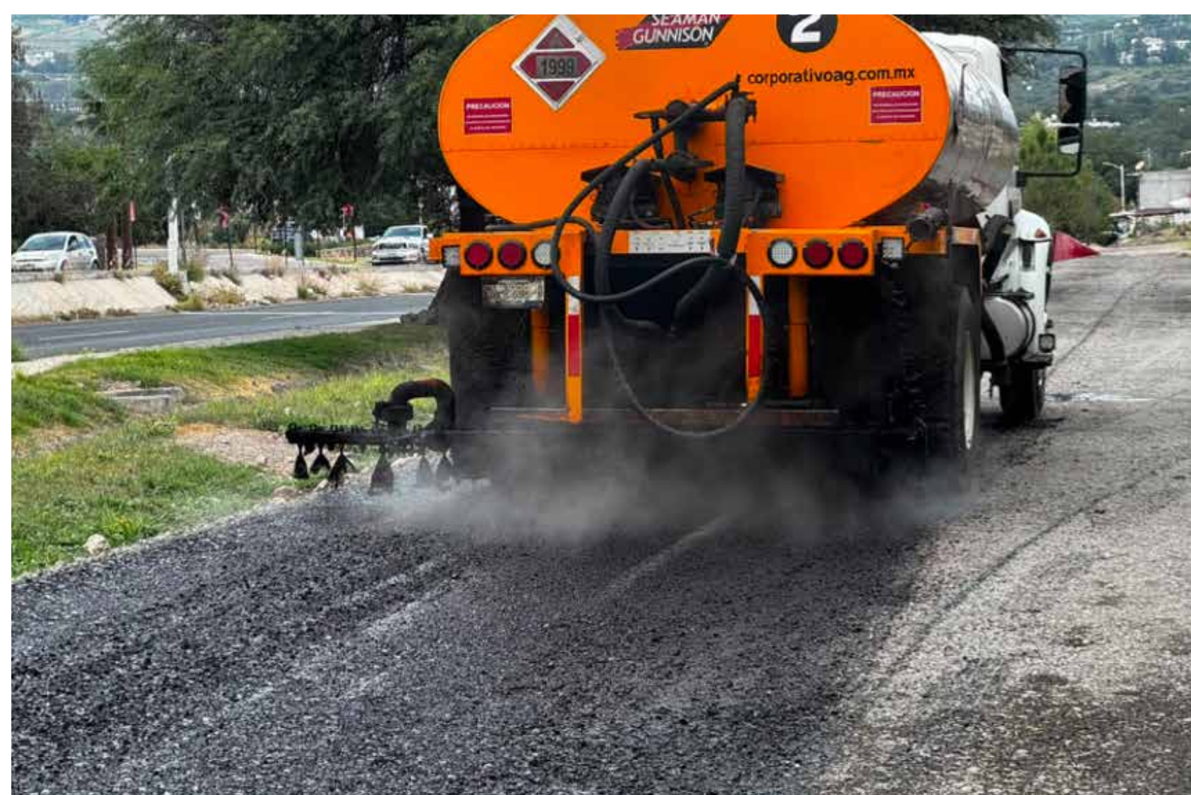
COMPACTACIÓN DE BASE HIDRAULICA Y RIEGO DE IMPREGNACIÓN
