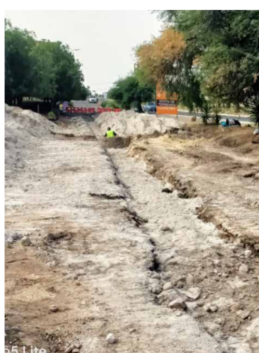
Drenaje sanitario en carril de incorporación
